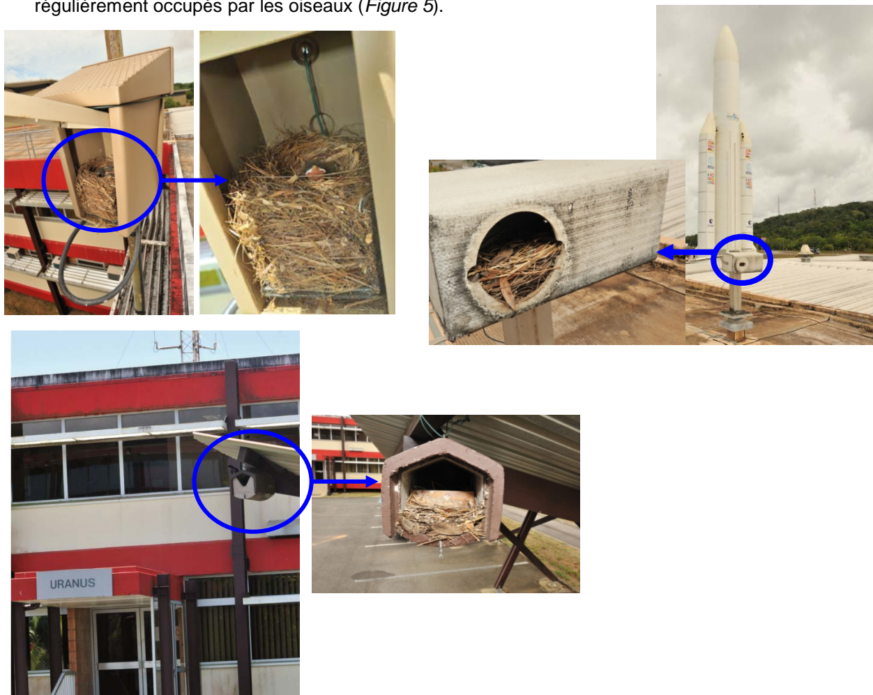
Figure 5 : Nichoirs sur le Centre Technique (CT).
